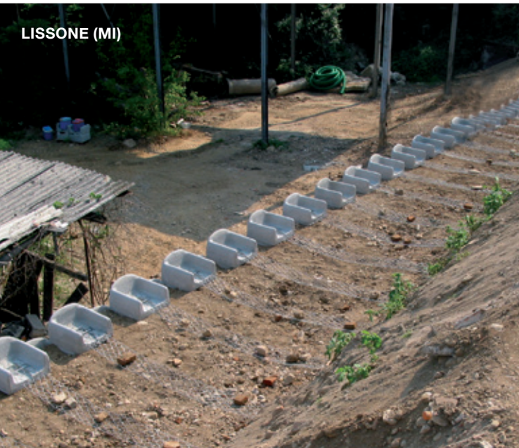
PARTICOLARE ANCORAGGIO RETE / BLOCCHI
